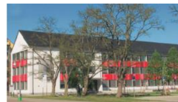
GeoSave 70 kW, Schwedt
